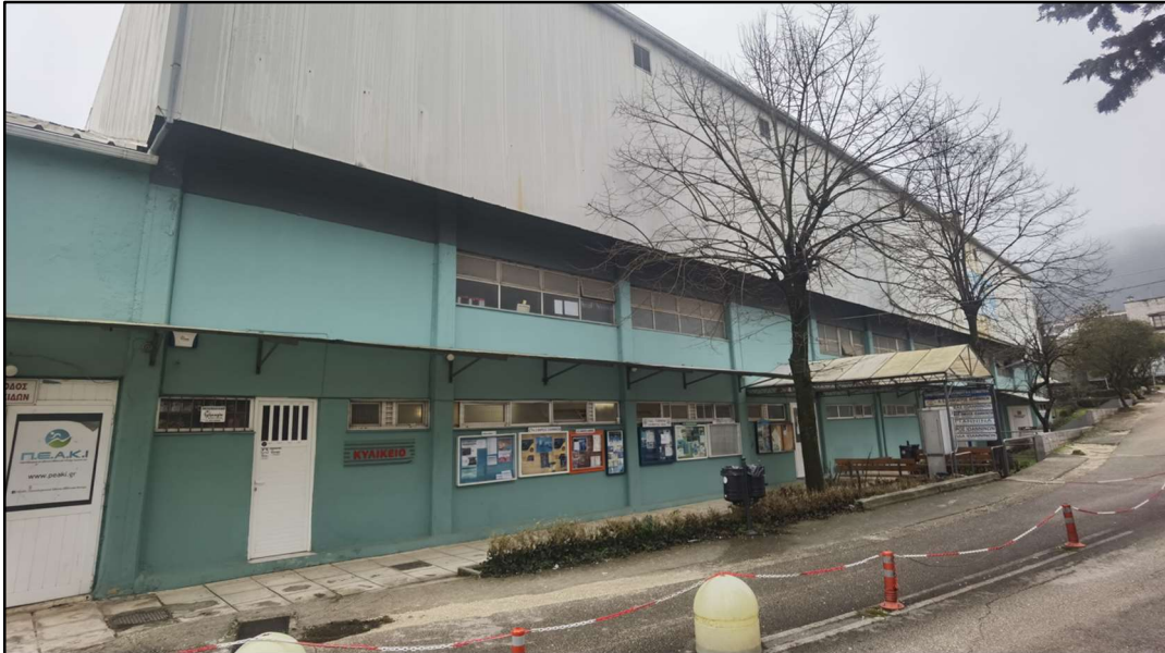
Εικόνα 4.1.3: Ενδεικτική παρουσίαση ανοιγμάτων στην τοιχοποιία των κερκίδων, ΒΔ πλευρά του κτιρίου
