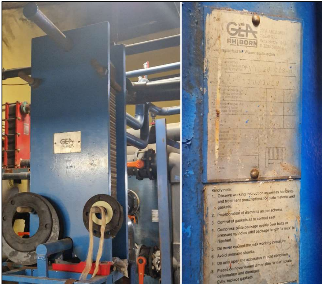
Εικόνα 3.2.5: Πλακοειδής εναλλάκτη της μεγάλης πισίνας
