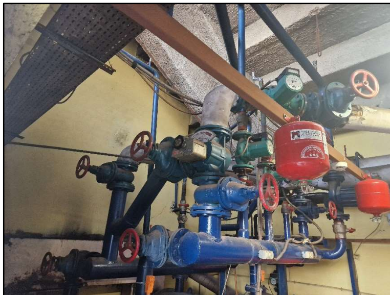
Εικόνα 3.2.3. Κεντρικός Συλλέκτης για τη διανομή θερμικής ενέργειας στις εγκαταστάσεις
