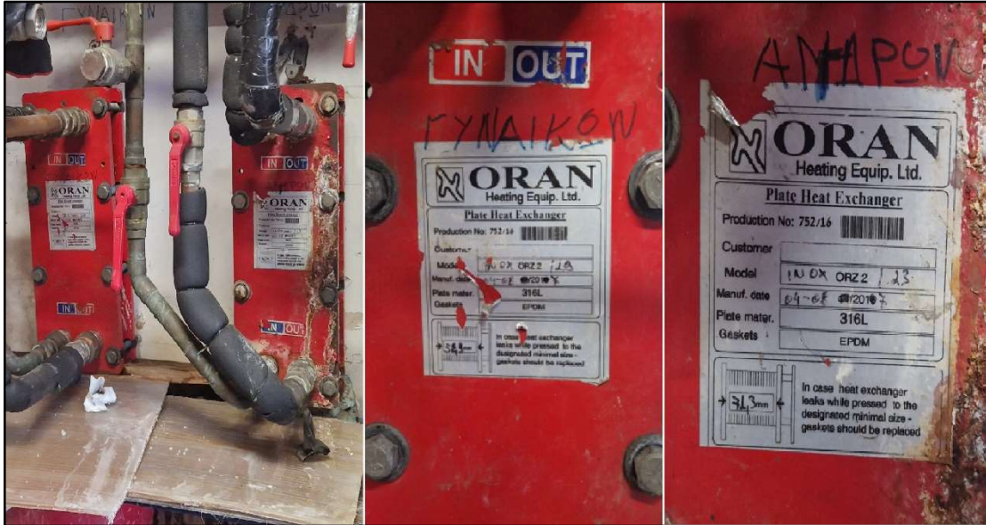
Εικόνα 3.2.7: Πλακοειδής εναλλάκτες για τη παραγωγή ζεστού νερού χρήσης
