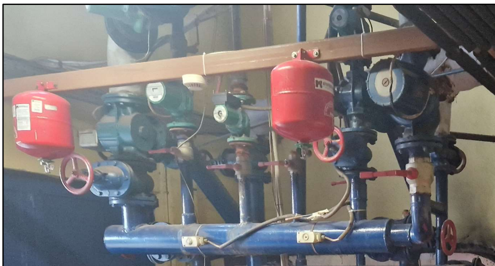
Εικόνα 3.2.3. Κεντρικός Συλλέκτης για τη διανομή θερμικής ενέργειας στις εγκαταστάσεις
