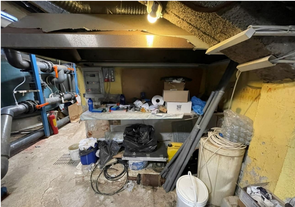
Εικόνα 6.7.2 Χώρος Εγκατάστασης Νέου Πίνακα Χαμηλής Τάσης
