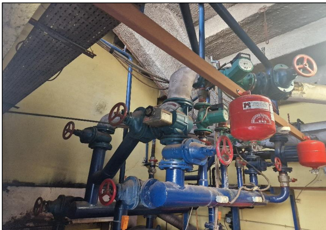
Εικόνα 3.3.5 Κεντρικός Συλλέκτης για τη διανομή θερμικής ενέργειας στις εγκαταστάσεις
