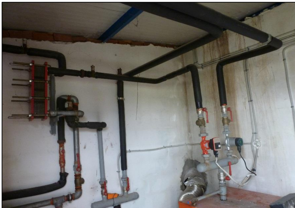
Εικόνα 3.3.10 Δίκτυο διανομής λεβητοστασίου αποδυτηρίων μικρής πιέσεως
