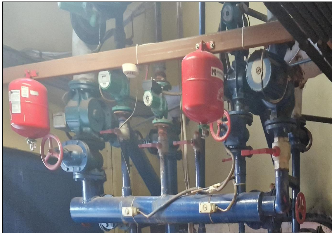
Εικόνα 3.3.6 Κυκλοφορητές κλάδων κεντρικού συλλέκτη
