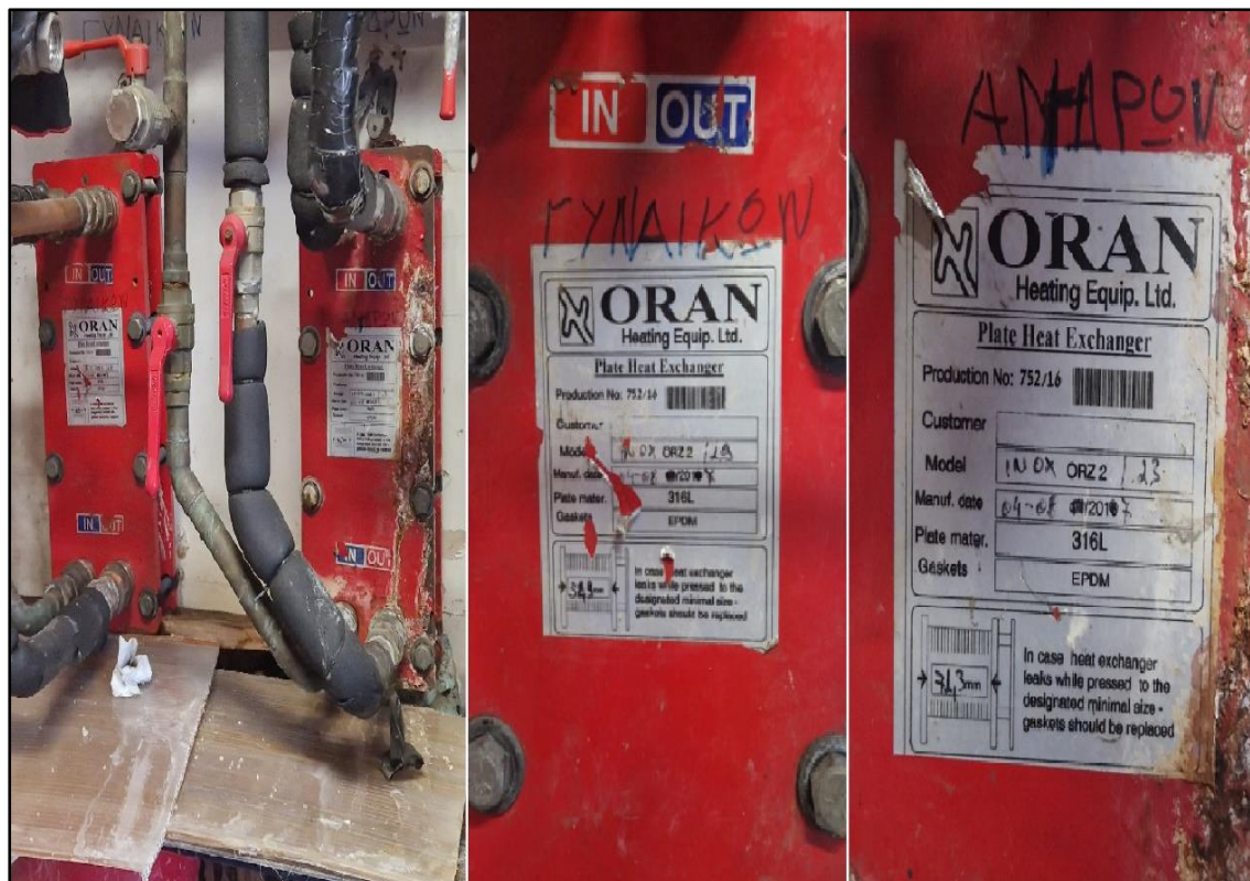
Εικόνα 3.3.9 Πλακοειδής εναλλάκτες για τη παραγωγή ζεστού νερού χρήσης
