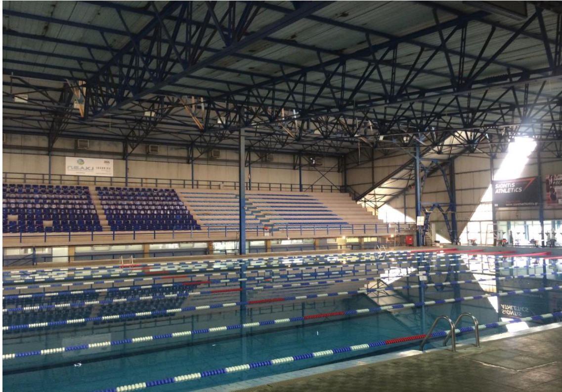
Εικόνα 3.3.2. Υφιστάμενη κατάσταση φωτισμού πισίνας
