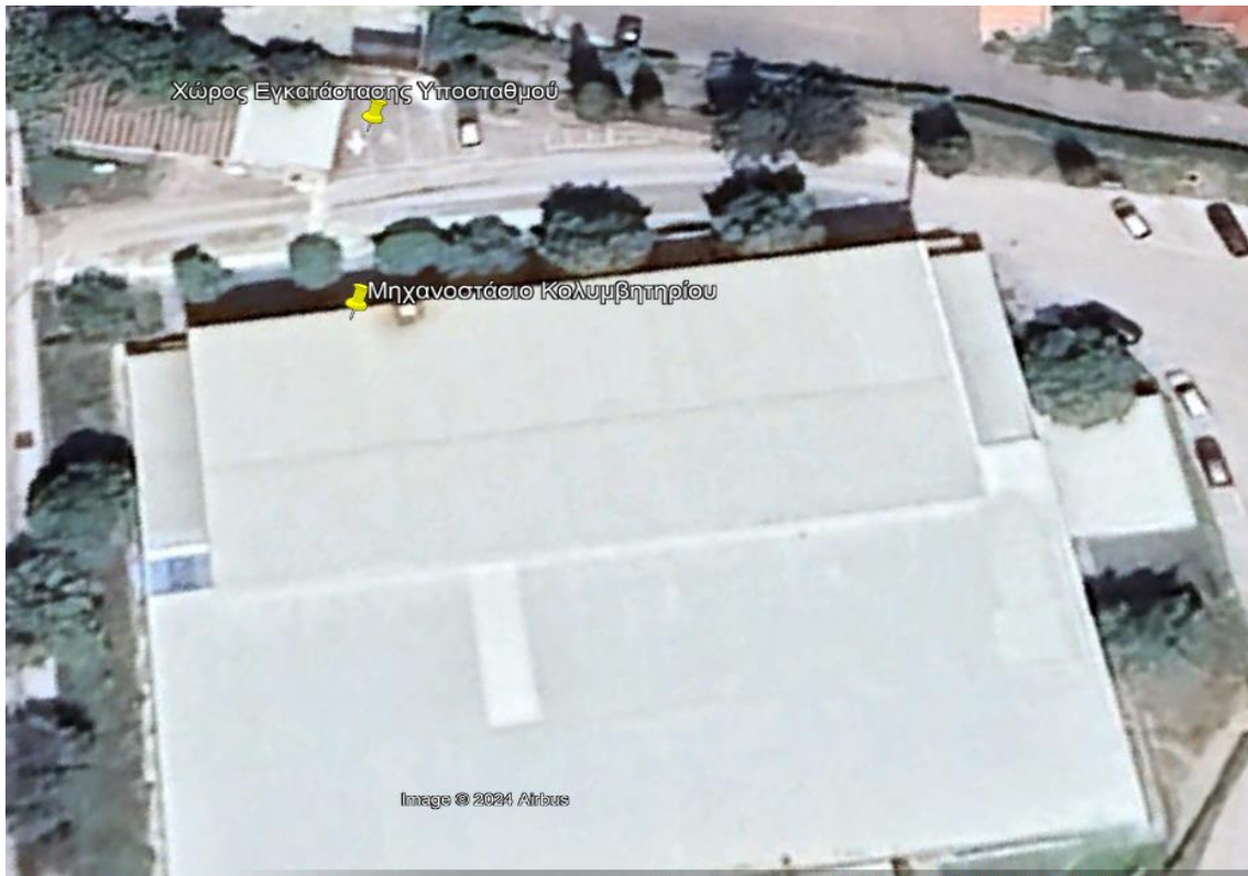
Εικόνα 6.7.1 Χώρος Εγκατάστασης ΥΣ 20/0.4 kV
