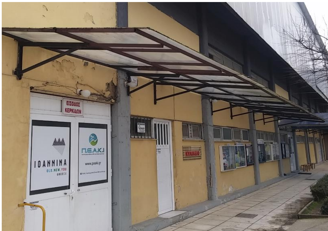
Εικόνα 3.3.1 Εξωτερικός χώρος κολυμβητηρίου
