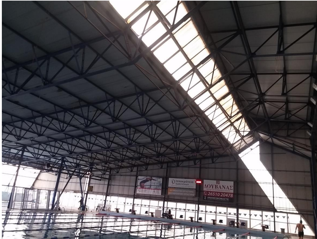
Εικόνα 4: Αποψη οροφής Κλειστού Κολυμβητηρίου Ιωαννίνων Εσωτερικά
