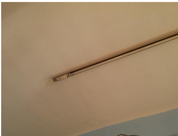
Εικόνα 6.1. Λαμπτήρες φθορισμού 1x36W (Αίθουσα αναμονής)
