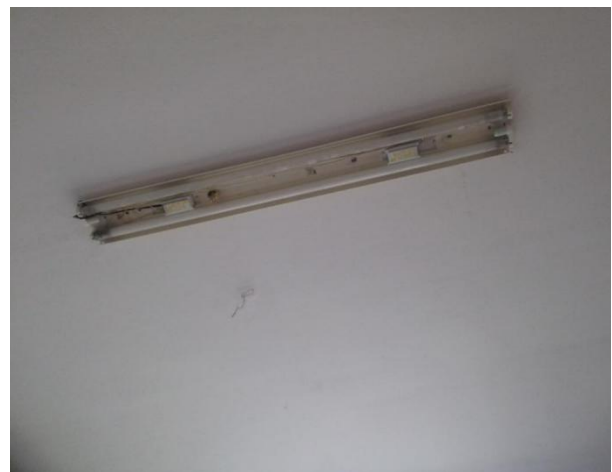
Εικόνα 6.2. Λαμπτήρες φθορισμού 2x36W (Αποδυτήρια)
