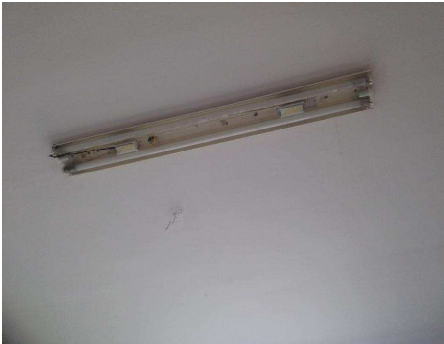
Εικόνα 6.2. Λαμπτήρες φθορισμού 2x36W (Αποδυτήρια)
